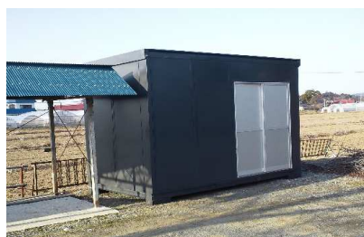
2月21日 倉庫設置
